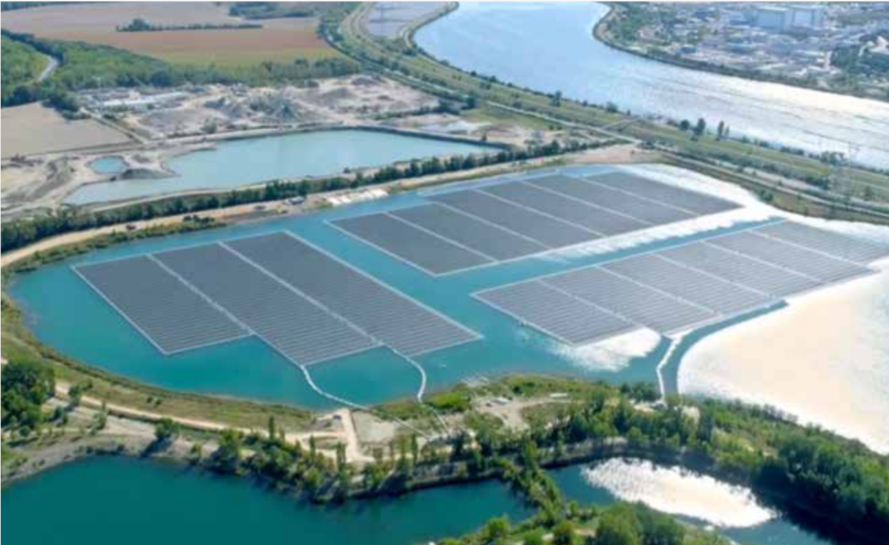
Figure 2-28 Centrale photovoltaïque flottante à Piolenc, en France [154]
