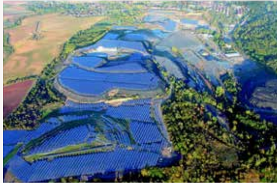
Figure 2-18 Parc solaire Krughütte de 29,1 MW à Eisleben, en Allemagne [110]
