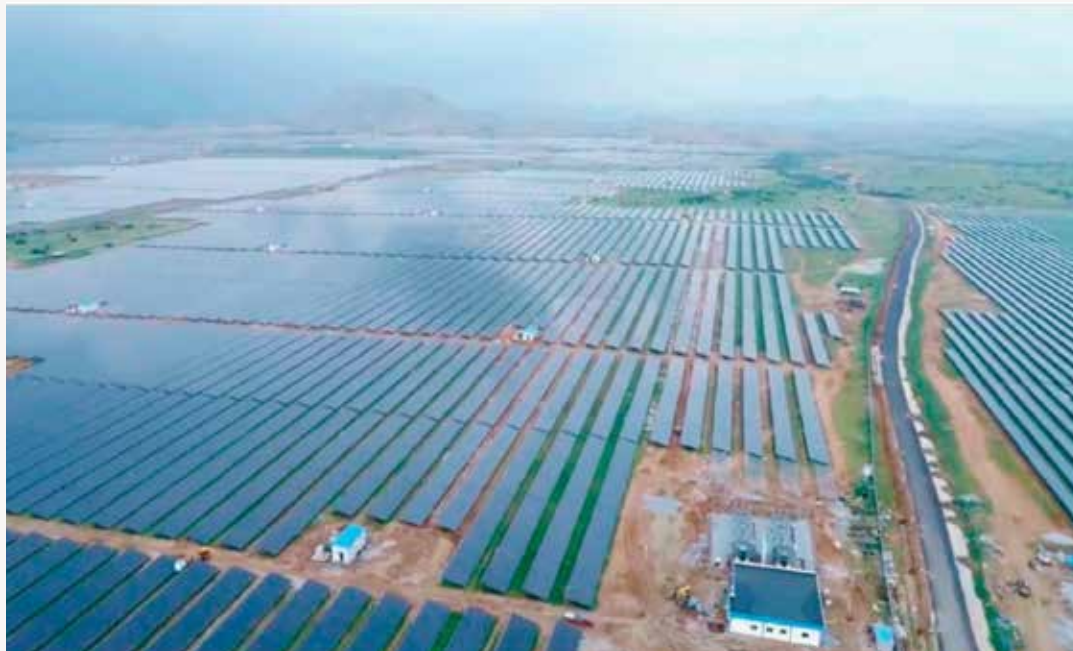
Figure 2-20 Centrale solaire de 2 050 MW à Pavagada, en Inde [125]
